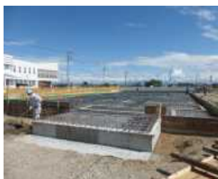
基礎のコンクリート
