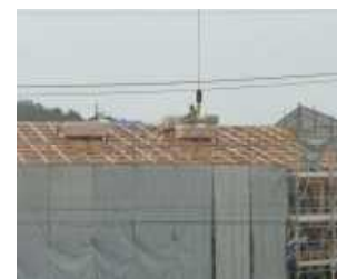
屋根の土台板がはられた様子
