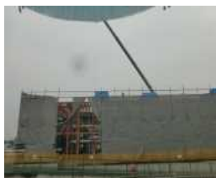
骨組みである鉄骨
